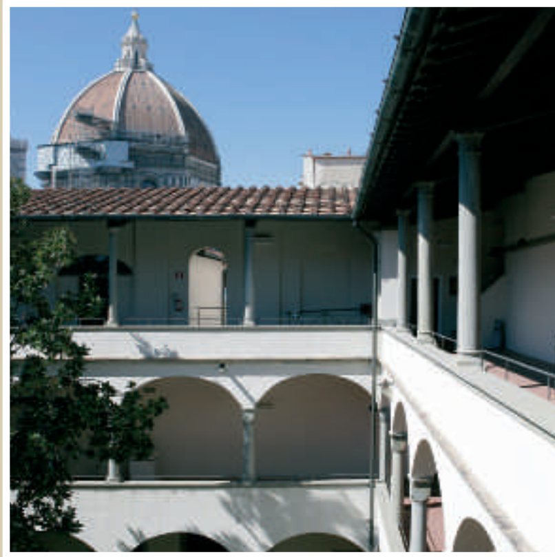
Fig. 1 Chiosstro trecentesco angolo nord-ovest, Biblioteca delle Oblate, Firenze
