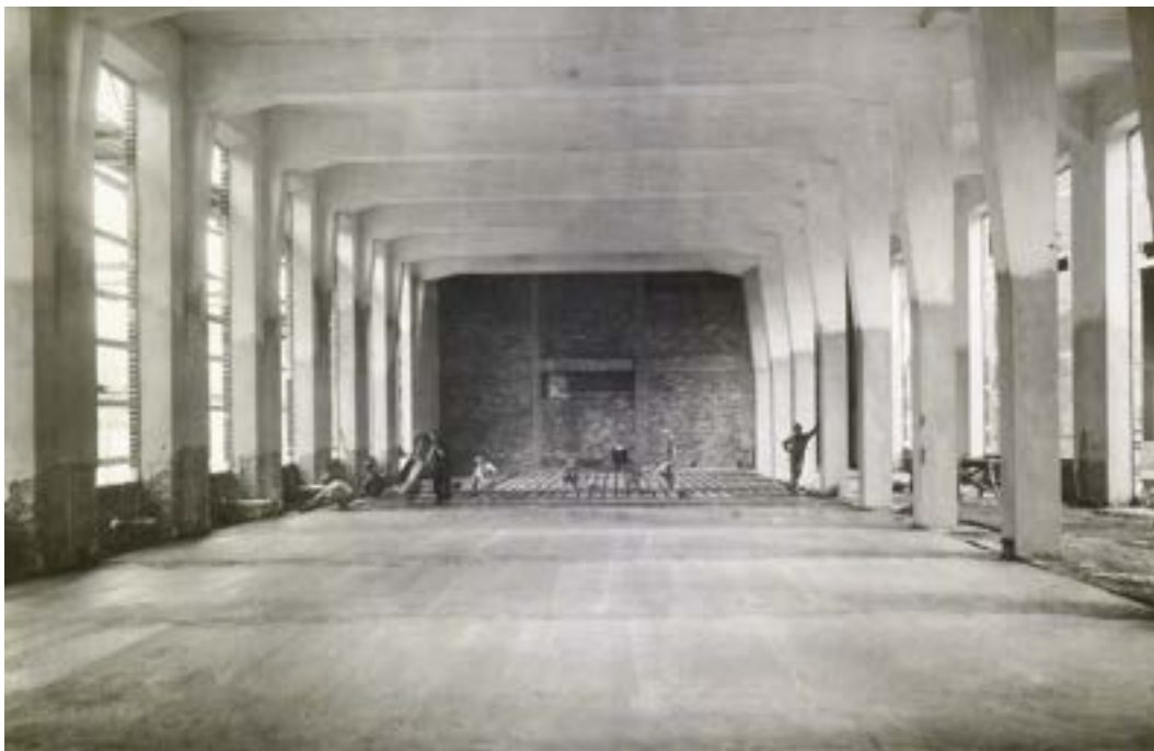
Fotografia realizzata durante il corso dei lavori per la costruzione della Casa del Balilla. 1936 marzo 3 iscr. Coll. CF car. 239/028
