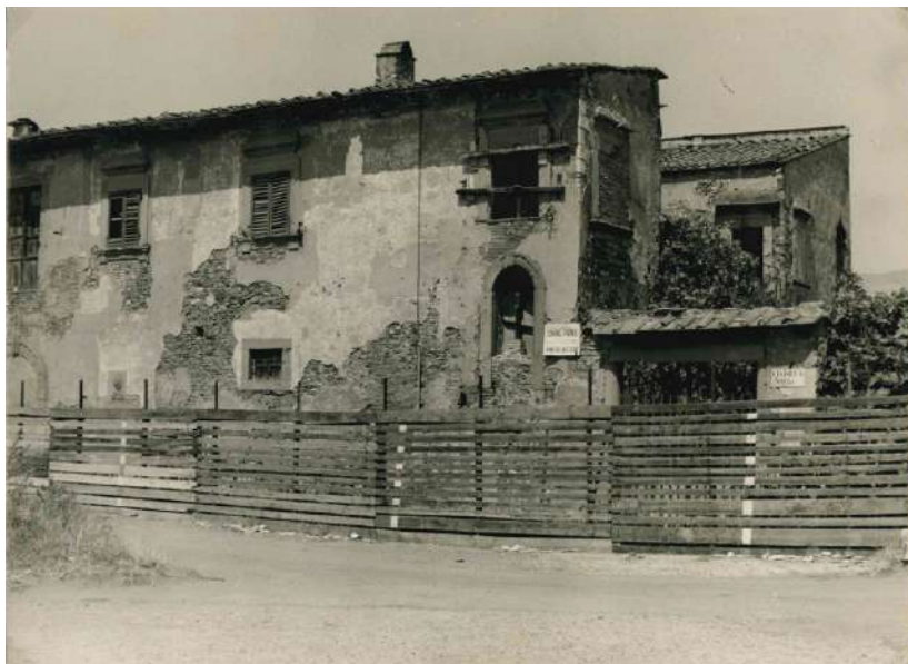
1975. Villa Pozzolini, lato destro della facciata 52 .
