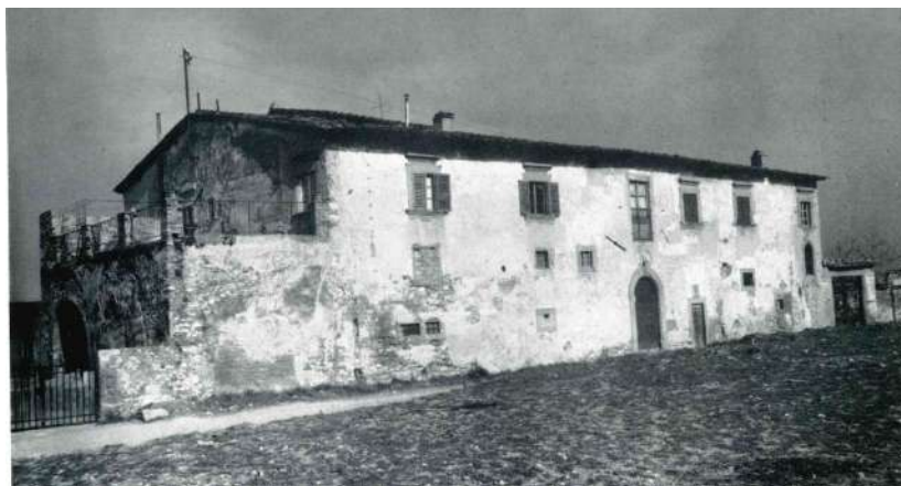
Villa Pozzolini prima dei lavori 70 .
