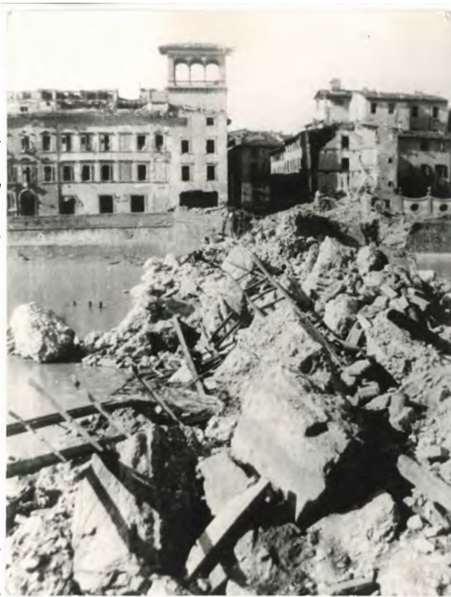
Dettaglio delle distruzioni di Ponte alla Carraia (Fototeca Isrt)
