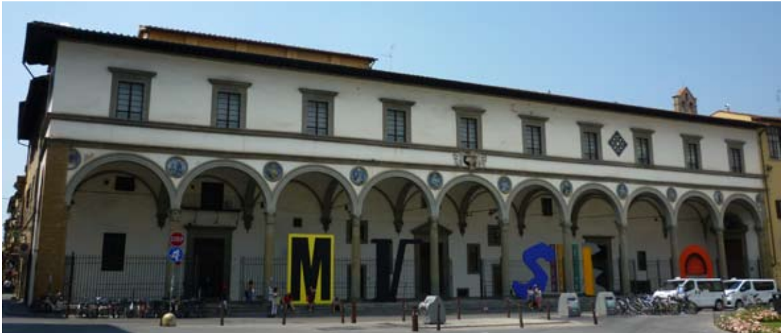
Figura 78. Facciata vista da Sud-Ovest dell'ex ospedale di San Paolo (piazza Santa Maria Novella) (Foto: autrice).
