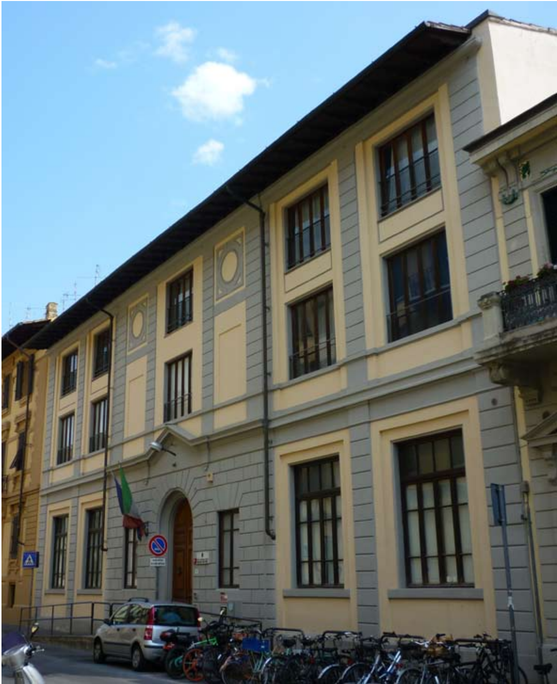
Figura 67. Facciata principale della scuola elementare statale Cesare Battisti (via Nove Febbraio, 18) (Foto: autrice).
