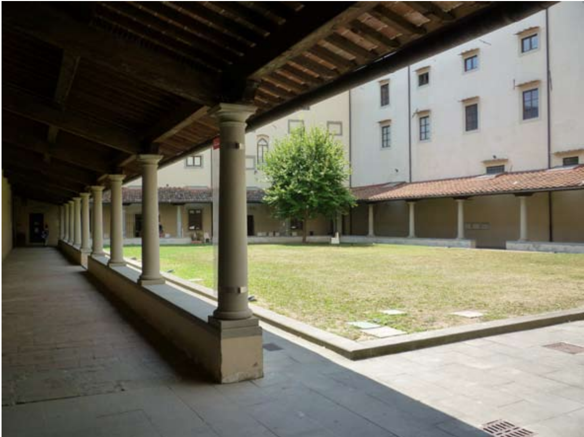
Figura 73. Aspetto attuale del chiostro dell'ex Conservatorio di San Salvatore (piazza Torquato Tasso) (Foto: autrice).
