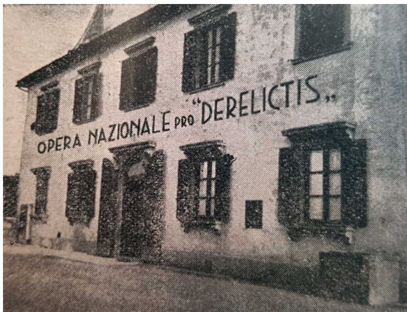
Facciata del lato Nord di Villa Salvini.
