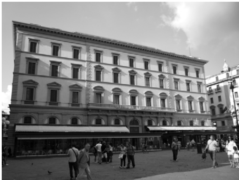
33 Aspetto attuale dell'edificio Levi (piazza della Repubblica), al cui pianoterra si trovano i caffè Gilli (a destra) e Paszkowski (a sinistra) (fotografia: autrice).
