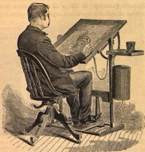
Fig. 309. — Apparecchio meccanico per disegni a penna in litografia, adottato per i ritocchi delle grandi positive fotografiche.
